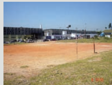
FOTO 3 Vista da área onde era realizada a pintura das estruturas metálicas.
