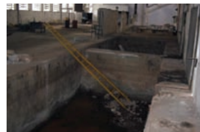
FOTO 5.13 Rebaixamentos que abrigaram tanques de galvanoplastia em uma indústria abandonada
