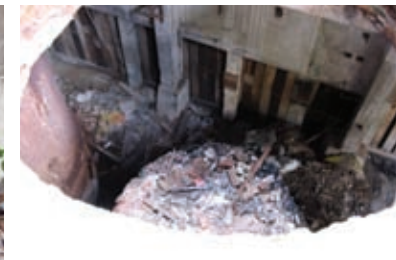
FOTO 5.12 Abertura e base de uma caldeira em uma indústria abandonada
