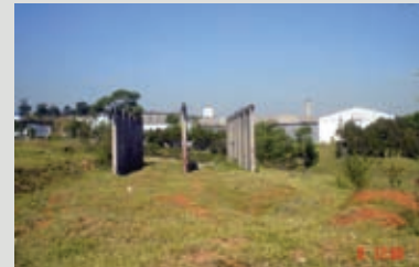
FOTO 6 Vista da área à frente do galpão onde era disposta a areia residual do jateamento das peças metálicas.
