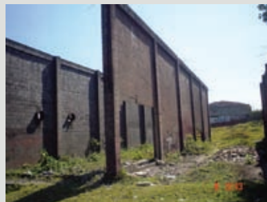
FOTO 2 Vista da área onde era realizado o jateamento abrasivo com areia (a seco) das peças metálicas.
